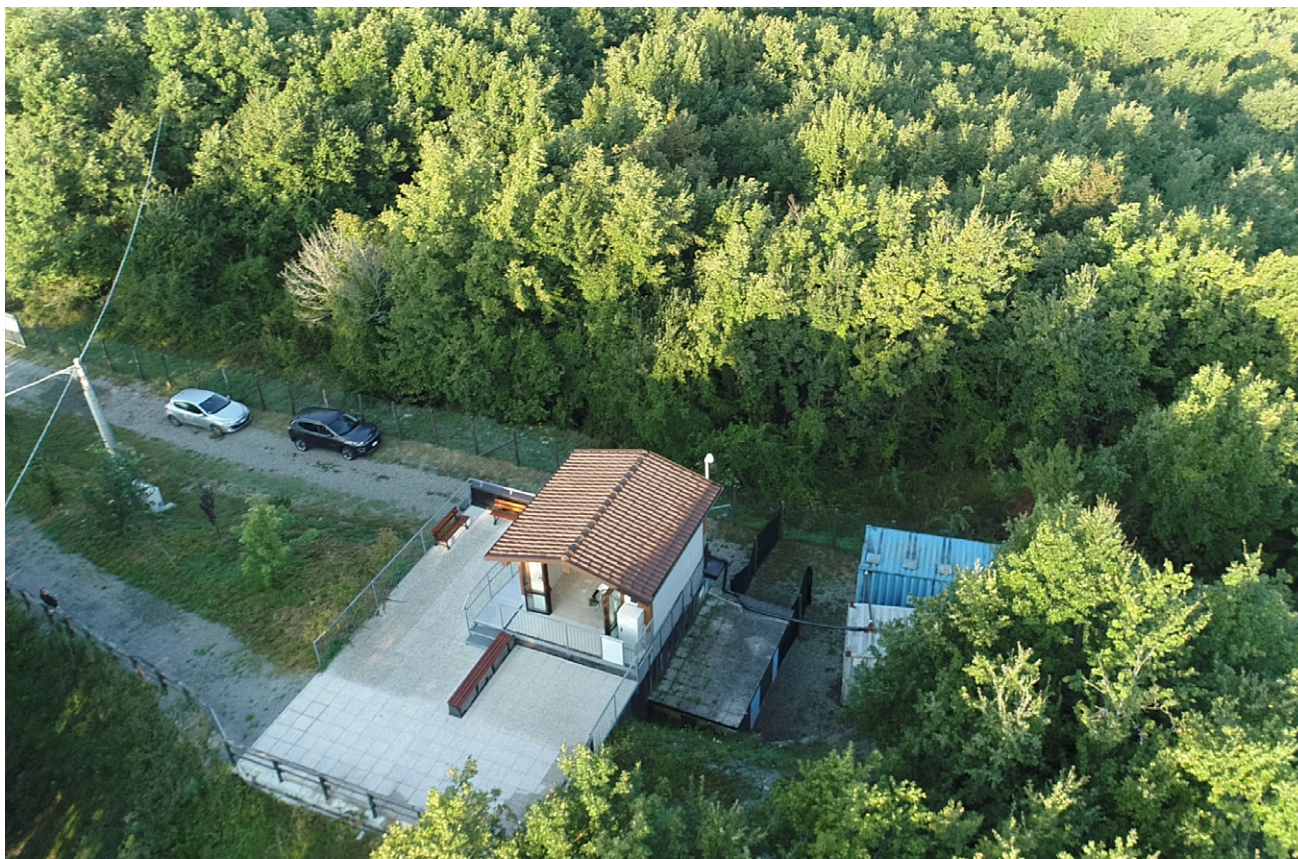
La Centrale Idroelettrica Nola-Fasso
